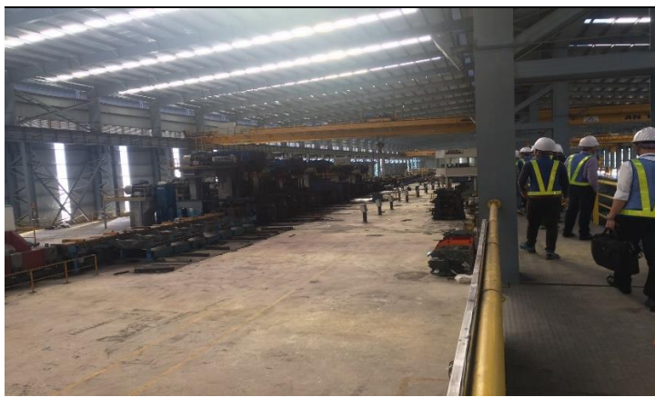
Hình 05. Nhà máy cán thép
