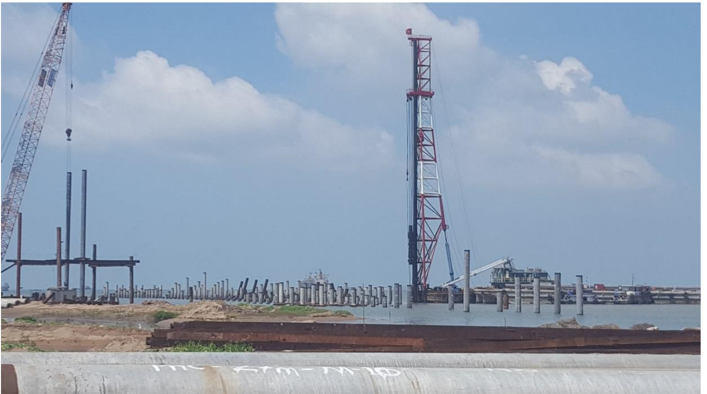
Đóng cọc thép cho 800m cầu bến chính của Giai đoạn 1
